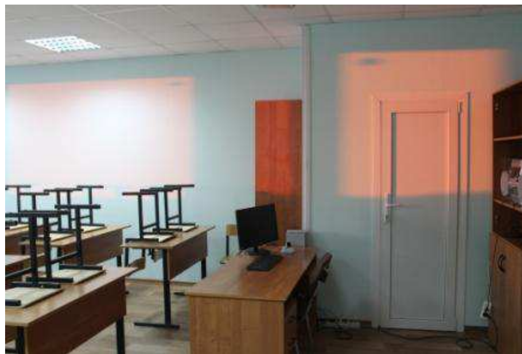
Проведен ремонт кабинета для индивидуальных занятий (1 этаж)
